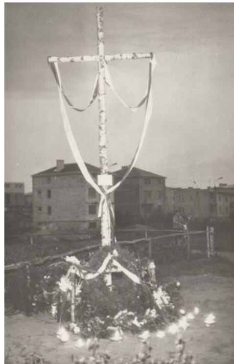
Krzyż postawiony 1.09.1981 r., przy którym została odprawiona msza św. na placu budowy kościoła
