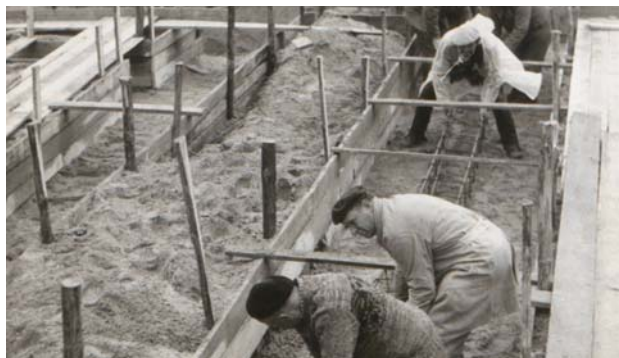
Przygotowywanie taw pod fundamenty
