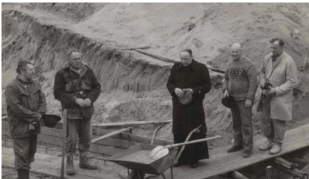
Modlitwa przed rozpoczęciem wylewania fundamentów pod kościół, 23.04.1985 r.
