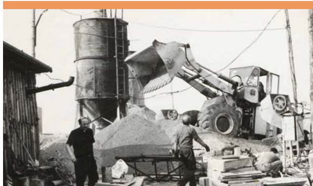
Ks. A. Chojnowski doglądający prac budowlanych
