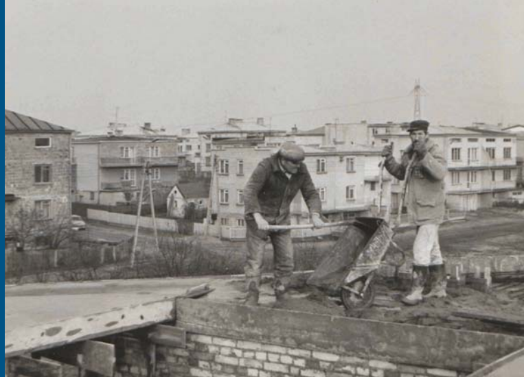
Zalewanie stropu
