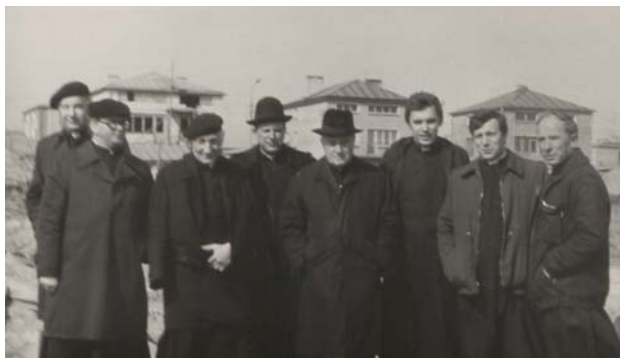
Księża: W. Ciereszko, K. Kułakowski, M. Stopczyński, A. Chojnowski, bp E. Kisiel, A. Skreczko, S. Hodun i H. Glinko na placu budowy kościoła, 1985 r.
