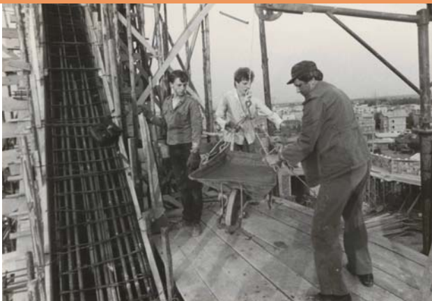
Parafianie pracujący na budowie świątyni
