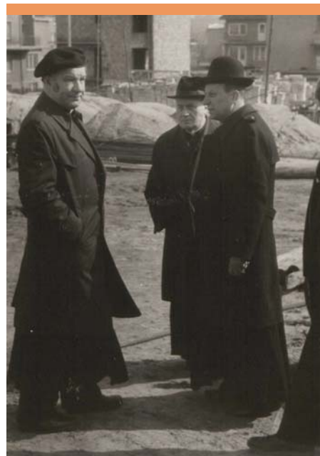
Ks. W. Ciereszko, bp E. Kisiel i ks. A. Chojnowski na placu budowy
