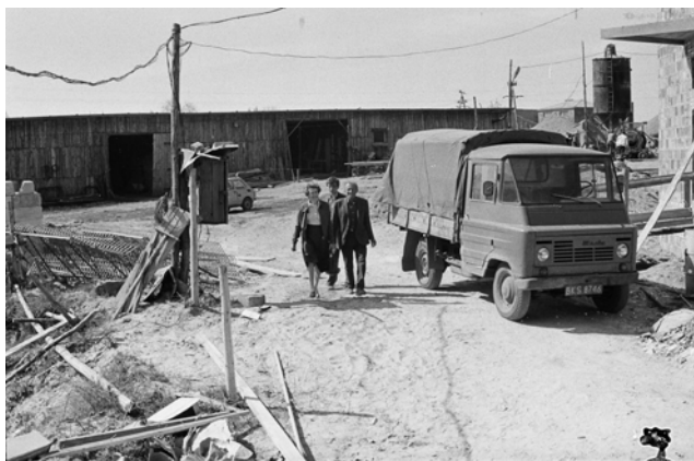
Architekt K. Drewnowska i nadzór budowlany na placu budowy
