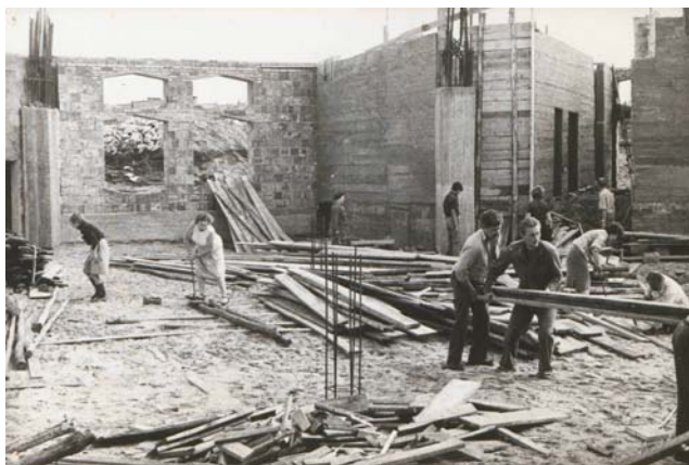
Na placu budowy
