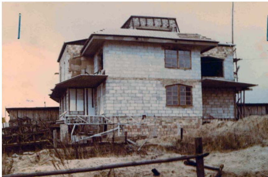
Plebania w trakcie budowy
