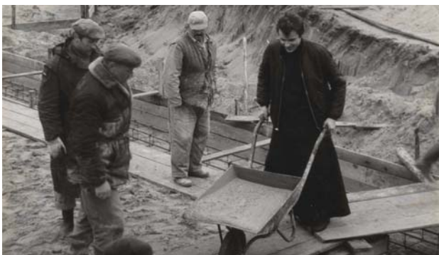
Ks. A. Skreczko przy zalewaniu fundamentów
