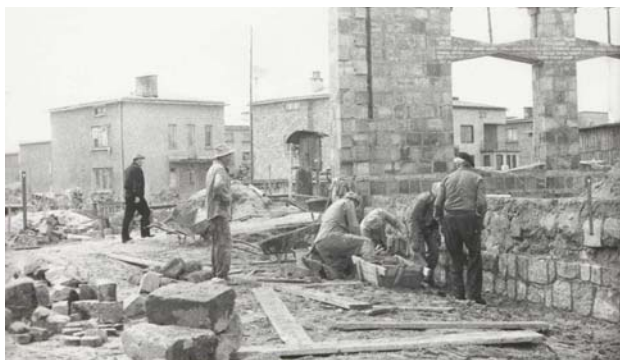
Układanie cokołu z kamienia wokół kościoła
