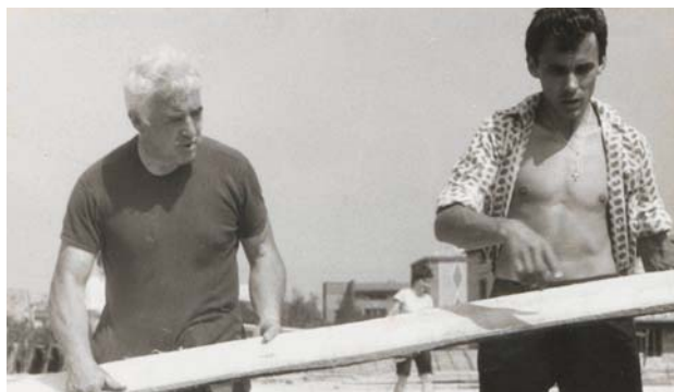
Ks. Adam Skreczko i ks. Kamilo Misiaen z Belgii na placu budowy
